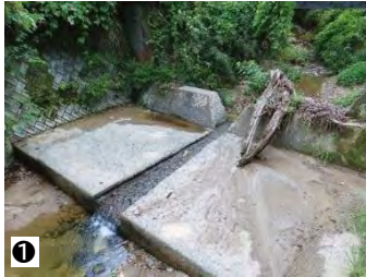
① 竜ノ口堰堤の切欠き魚道
